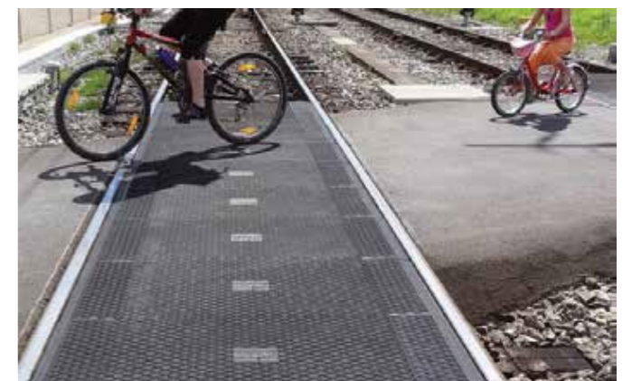
Zdjęcie 41 Bezrowkowy przejazd rowerowy przez linię kolejową. Niemcy
