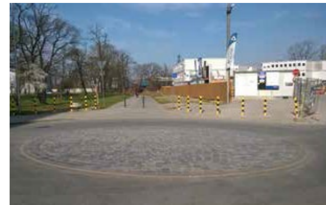
Zdjęcie 28 Droga dla rowerów jako samodzielny wlot na małe rondo. Wrocław, Polska
