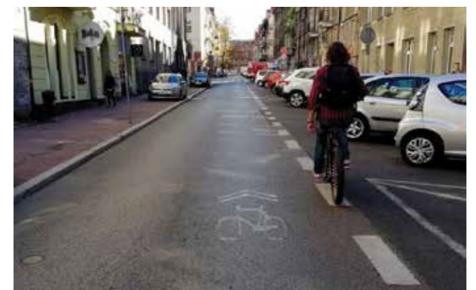
Zdjęcie 25 Kontraruch rowerowy. Katowice, Polska
