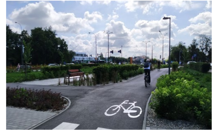
Zdjęcie 66 Oświetlenie drogi dla rowerów. Dąbrowa Górnicza, Polska
