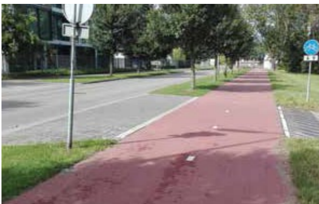
Zdjęcie 27 Wyniesienie drogi dla rowerów i chodnika przez drogę podporządkowaną
