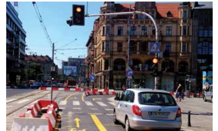
Zdjęcie 74 Tymczasowy pas ruchu dla rowerów z sygnalizatorem S-1a. Wrocław, Polska
