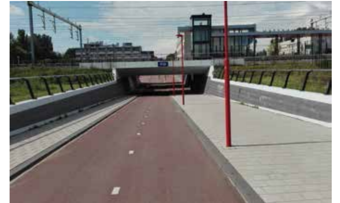
Zdjęcie 40 Bezkolizyjne skrzyżowanie linii kolejowej z główną drogą dla rowerów. Houten, Holandia
