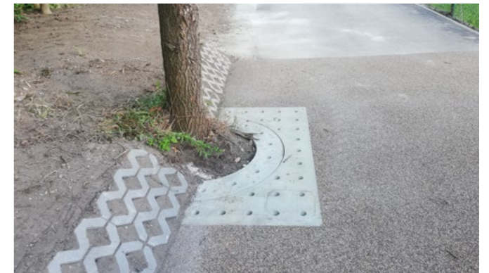
Zdjęcie 19 Ażurowa płyta w ciągu drogi dla rowerów nad korzeniami drzewa. Wrocław, Polska.
