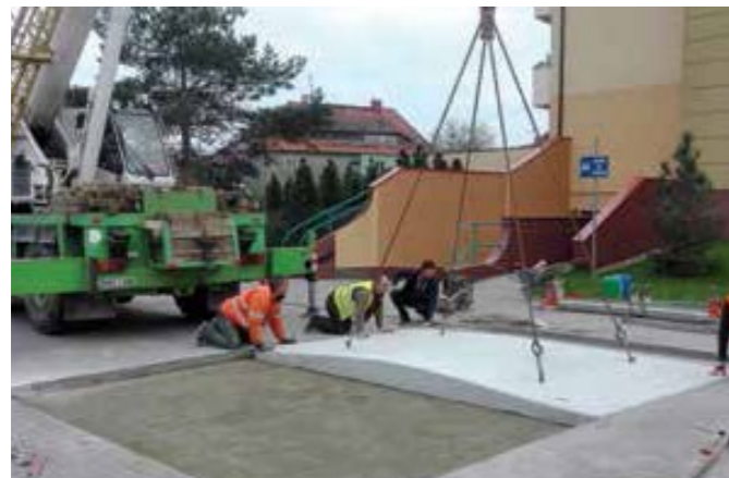
Zdjęcie 31 Montaż progów sinusoidalnych. Wrocław, Polska
