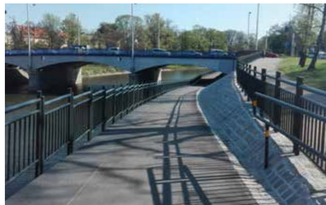
Zdjęcie 64 Kładka wzdłuż Odry pod istniejącym mostem. Wrocław, Polska
