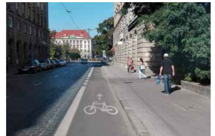
Zdjęcie 24 Asfaltowy kontrapas rowerowy na jezdni z kostki kamiennej. Wrocław, Polska
