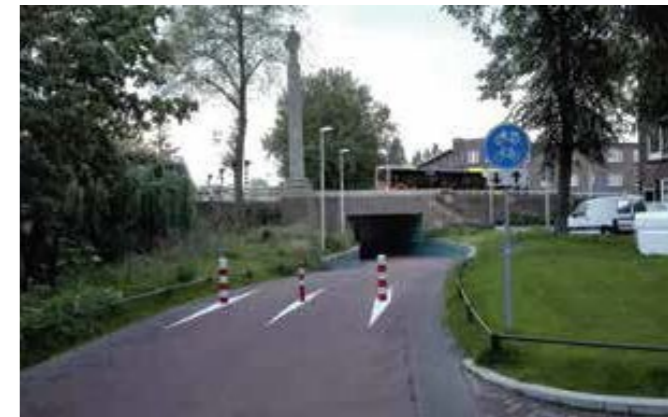
Zdjęcie 12 Tunel rowerowy pod wyniesioną jezdnią. Amsterdam, Holandia
