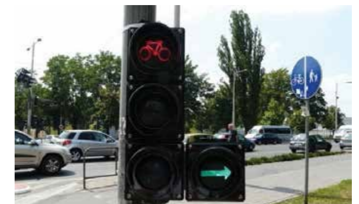
Zdjęcie 50 Sygnalizator S-1a z warunkową strzałką do skrzyżowania w prawo – sygnalizator na końcu kontrapasa rowerowego zapewnia relację niedostępną dla ruchu samochodowego
