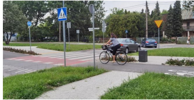
Zdjęcie 36 Droga dla rowerów z zachowaną ciągłością niwelety i nawierzchni przez drogę podporządkowaną. Dąbrowa Górnicza, Polska
