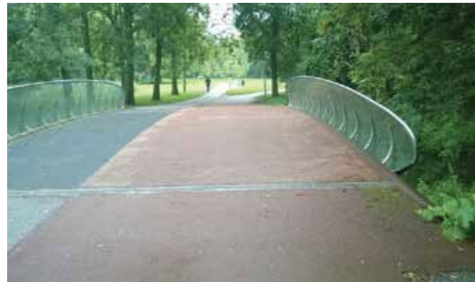
Zdjęcie 63 Kładka z barierą łukową. Amsterdam, Holandia
