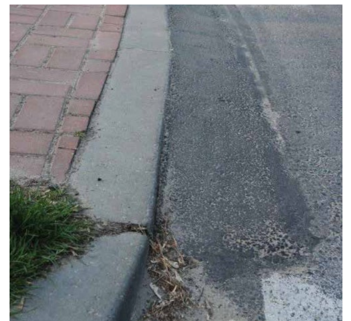
Zdjęcie 75 Wylewka z masy bitumicznej umożliwiająca wjazd na krawężnik – rozwiązanie tymczasowe. Wrocław, Polska
