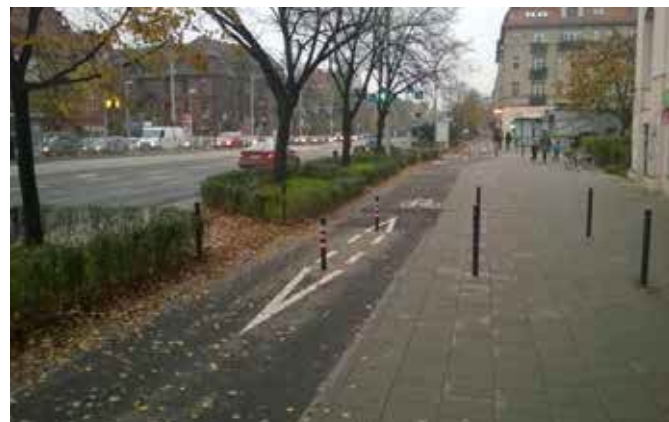
Zdjęcie 69 Stłupki blokujące dwukierunkową drogę dla rowerów przed wjazdem samochodów. Wrocław, Polska
