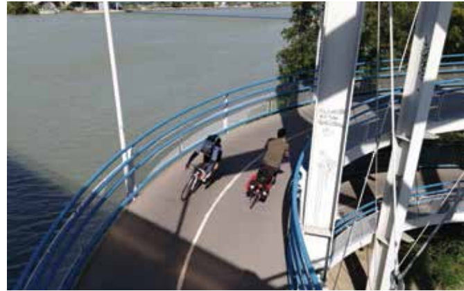
Zdjęcie 62 Pochylnia łącząca drogę dla rowerów z terenem skracającą w lewo w dół.
