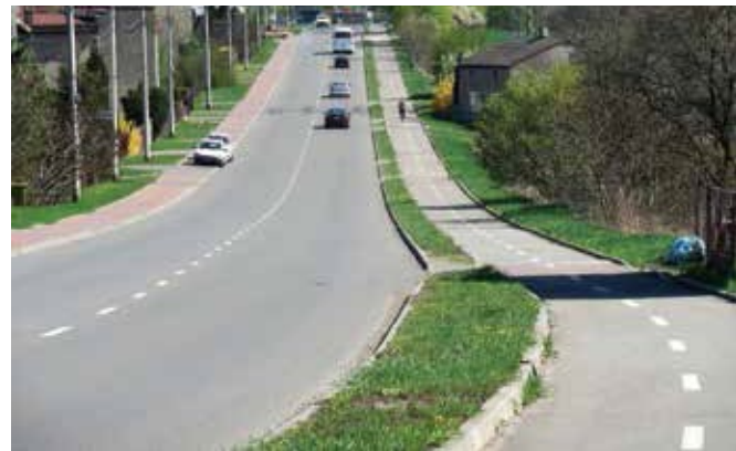
Zdjęcie 10 Linia osiowa na dwukierunkowej drodze dla rowerów. Będzin, Polska
