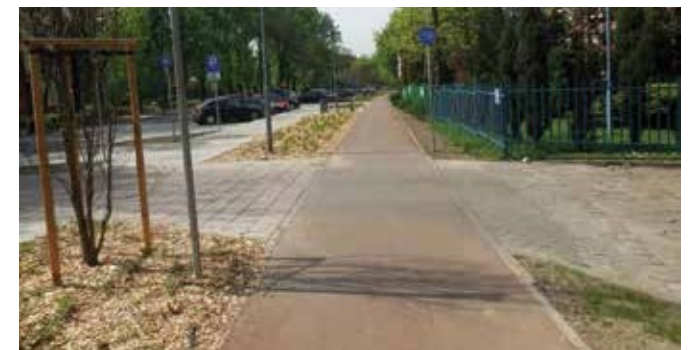
Zdjęcie 19 Ażurowa płyta w ciągu drogi dla rowerów nad korzeniami drzewa. Wrocław, Polska.
