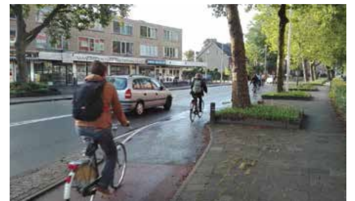
Zdjęcie 47 Zjazd z drogi dla rowerów na pas ruchu dla rowerów z ostoją tzw. „pleców”. Utrecht, Holandia
