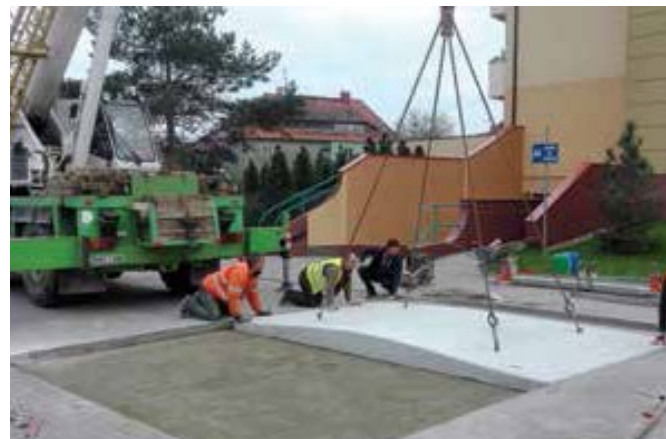
Zdjęcie 31 Montaż progów sinusoidalnych. Wrocław, Polska
