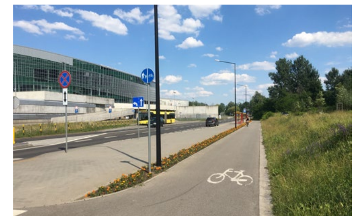
Zdjęcie 16 Separacja drogi dla rowerów od chodnika przy pomocy zieleni. Gliwice, Polska
