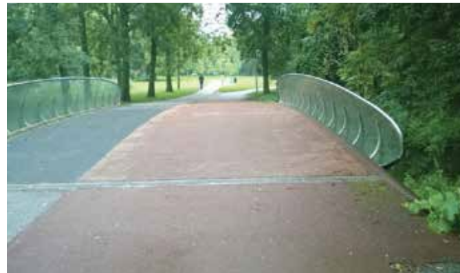
Zdjęcie 63 Kładka z barierą łukową. Amsterdam, Holandia
