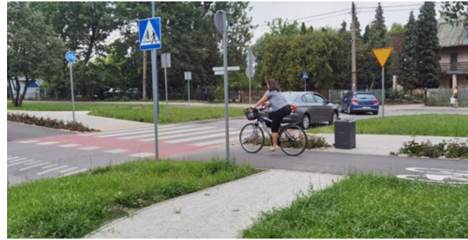
Zdjęcie 36 Droga dla rowerów z zachowaną ciągłością niwelety i nawierzchni przez drogę podporządkowaną. Dąbrowa Górnicza, Polska
