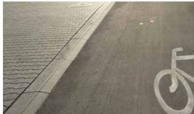
Zdjęcie 17 Obniżenie drogi dla rowerów względem chodnika przy pomocy krawężnika ułożonego „na płask”. Wroclaw, Polska
