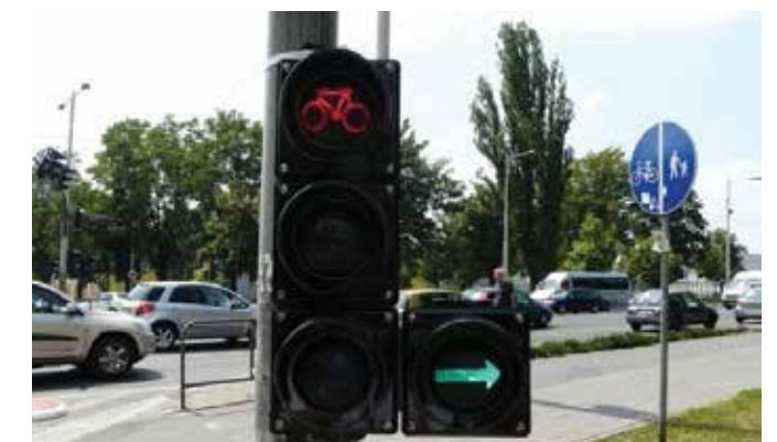
Zdjęcie 50 Sygnalizator S-1a z warunkową strzałką do skrzyżowania w prawo – sygnalizator na końcu kontrapasa rowerowego zapewnia relację niedostępną dla ruchu samochodowego
