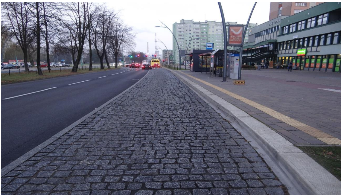
Rysunek 2 Zatoka autobusowa z kostki granitowej na przystanku Tychy Tęcza Źródło: opracowanie własne
