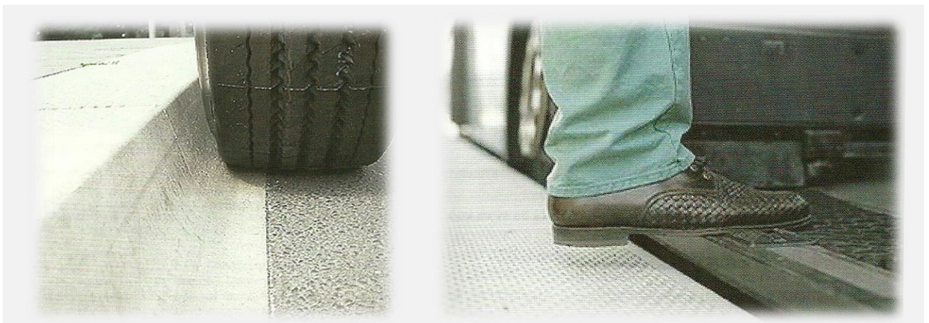
Rysunek 31 Profilowane krawężniki peronowe na przystanku
