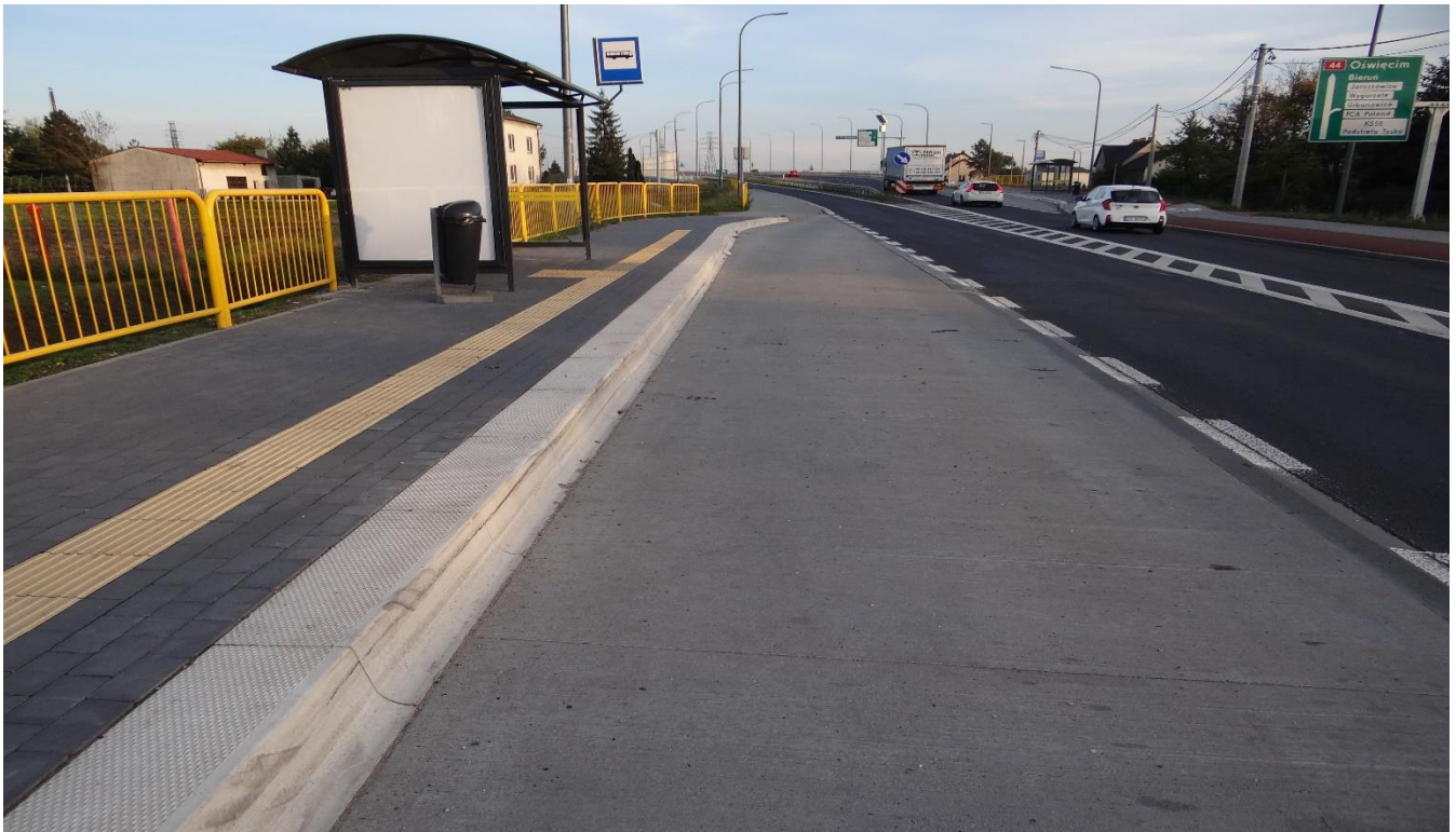
Rysunek 3 Zatoka autobusowa o nawierzchni betonowej na przystanku Tychy Urbanowice Źródło: opracowanie własne
