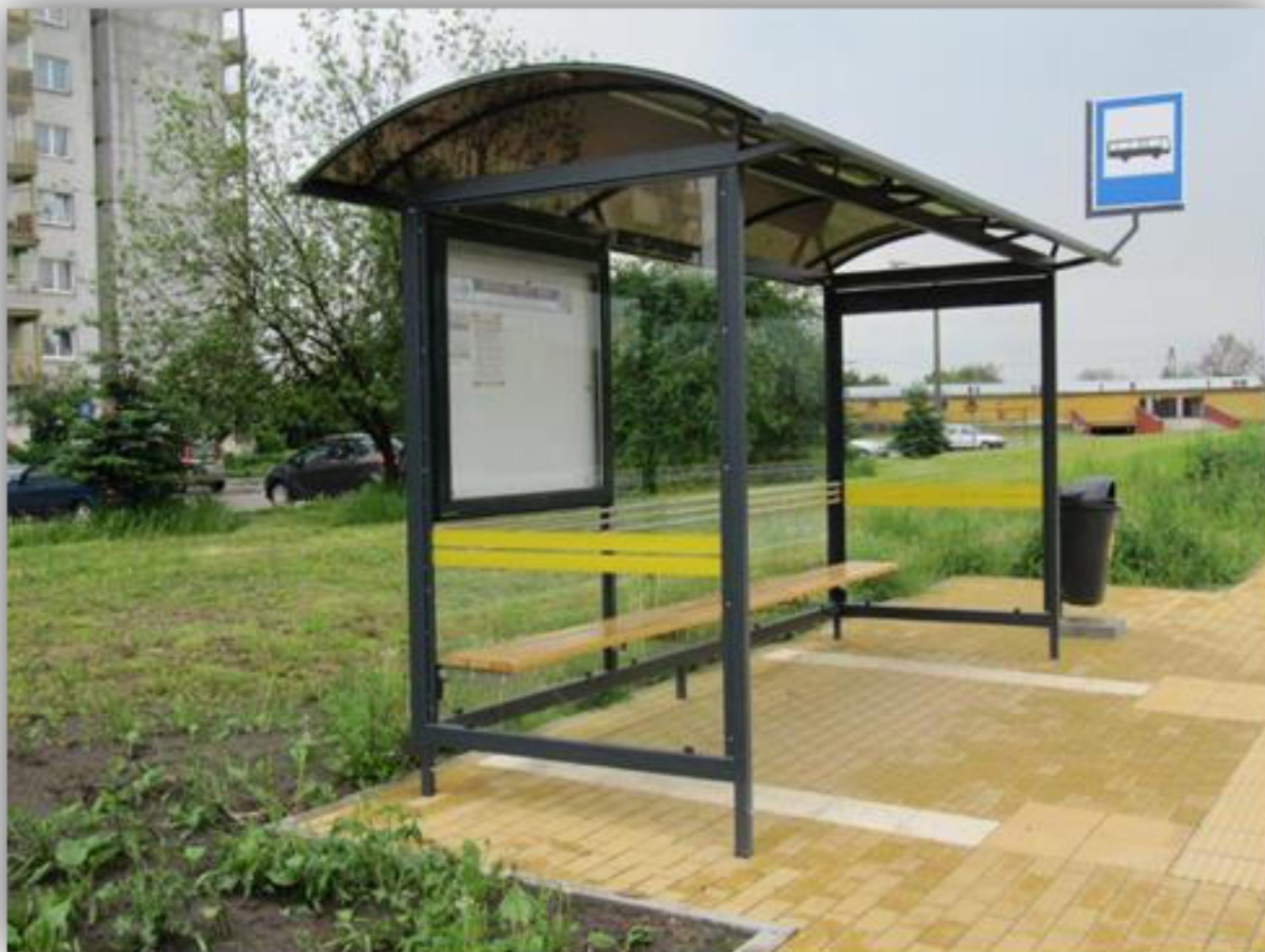
Rysunek 35 Kosz na śmieci na przystanku poza wiatą - zdjęcie poglądowe Źródło: opracowanie własne
