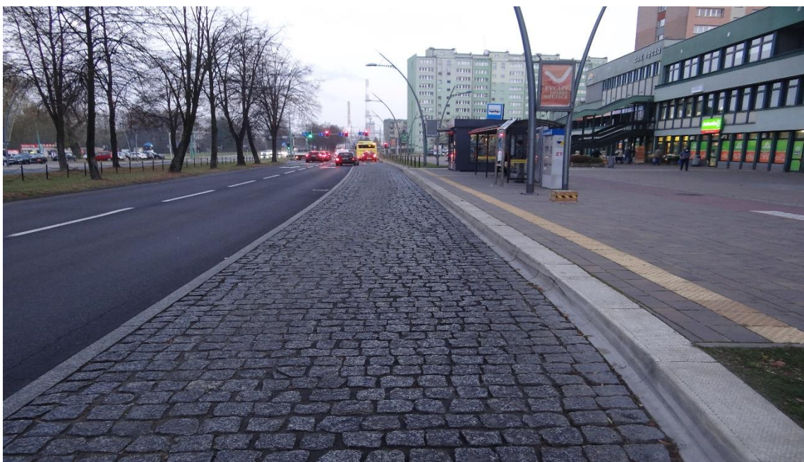
Rysunek 2 Zatoka autobusowa z kostki granitowej na przystanku Tychy Tęcza Źródło: opracowanie własne
