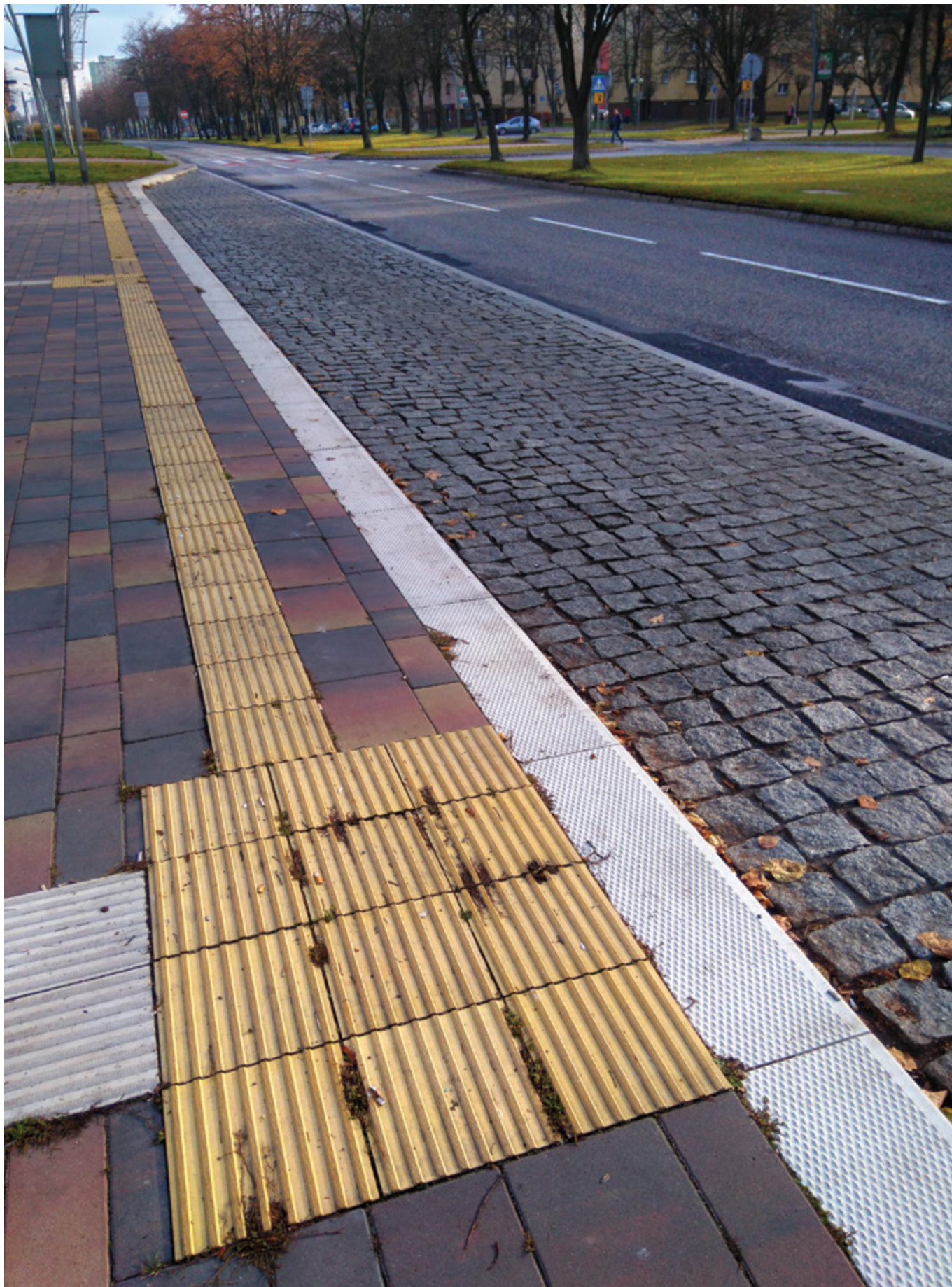
Krawężnik naprowadzający, Tychy (fot. Anna Staniek)
