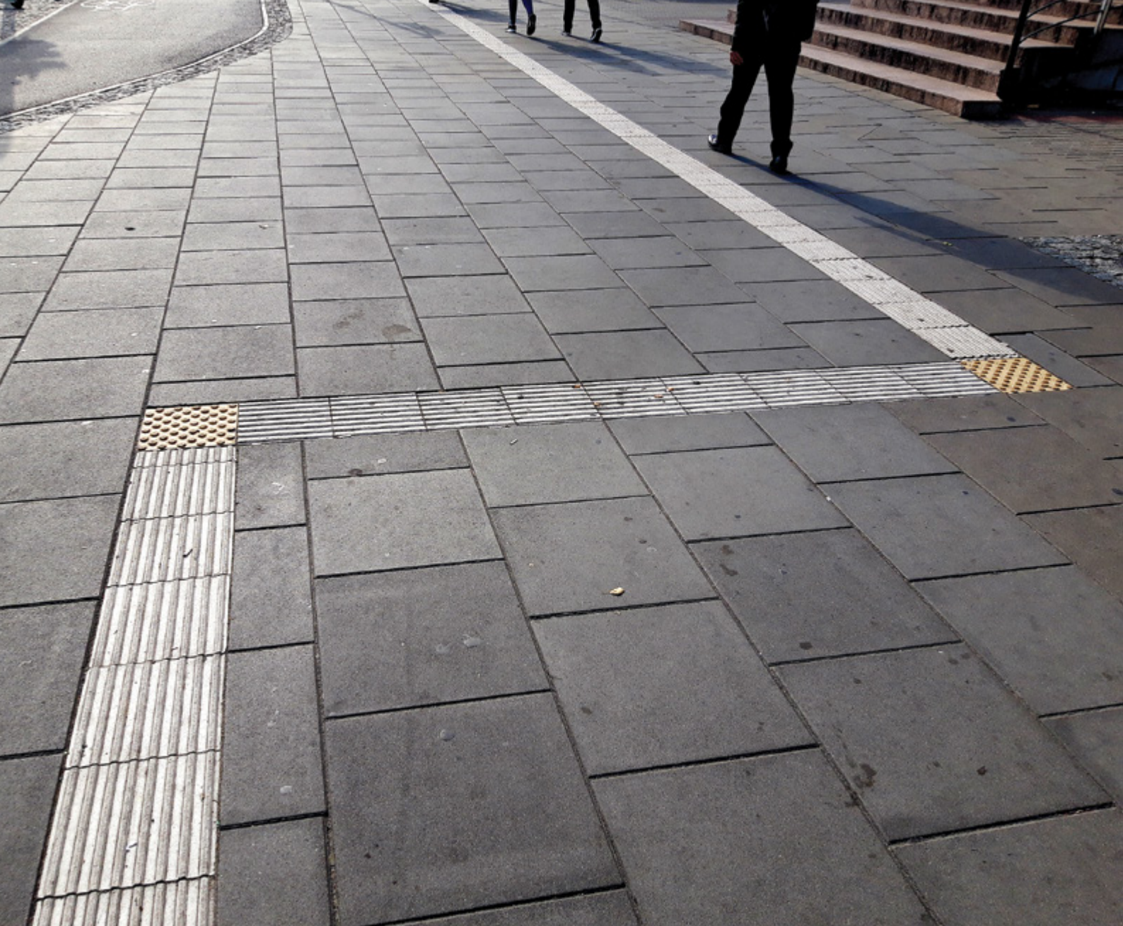
System prowadzenia w mieście. Na górze pola uwagi i pasy prowadzące. Na dole pas ostrzegawczy, Warszawa (fot. Grzegorz Wójkowski)
