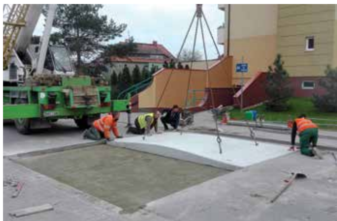
Zdjęcie 31 Montaż progu sinusoidalnego. Wrocław, Polska
