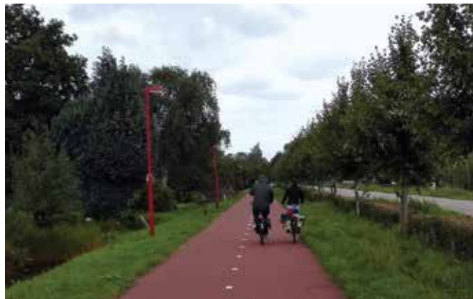
Zdjęcie 66 Oświetlenie drogi dla rowerów. Utrecht, Holandia
