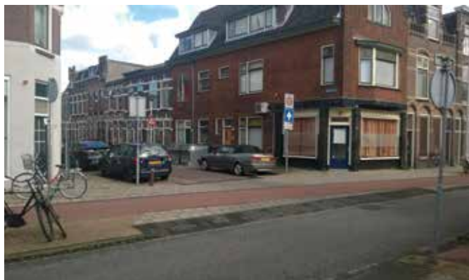
Zdjęcie 36 Droga dla rowerów z zachowaną ciągłością niwelety i nawierzchni przez drogę podporządkowaną. Amsterdam, Holandia
