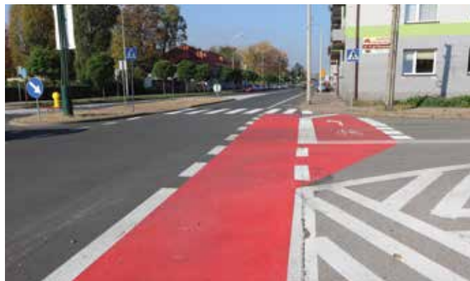
Zdjęcie 44 Śluzą dla rowerów – typ II. Będzin, Polska UWAGA błędnie zastosowano linię P-4
