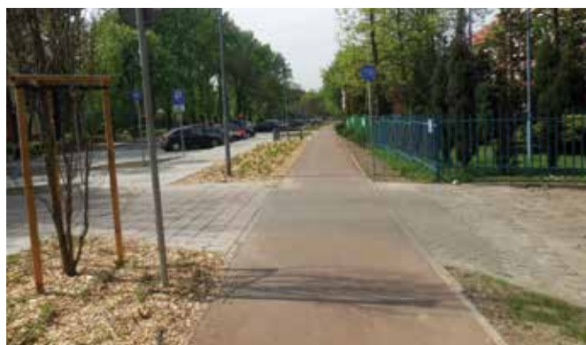
Zdjęcie 20 Ciągłość nawierzchni drogi dla rowerów przez zjazd. Sosnowiec, Polska
