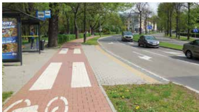
Zdjęcie 21 Tychy, Polska (uwaga - niewłaściwa nawierzchnia drogi dla rowerów)
