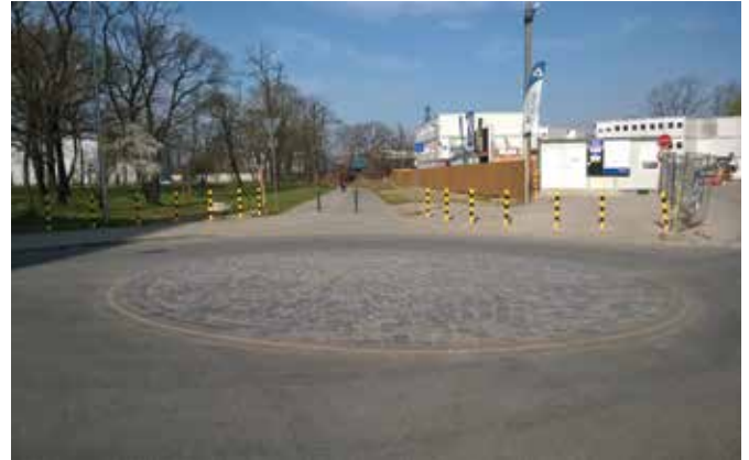
Zdjęcie 28 Droga dla rowerów jako samodzielny wlot na małe rondo, Wrocław, Polska
