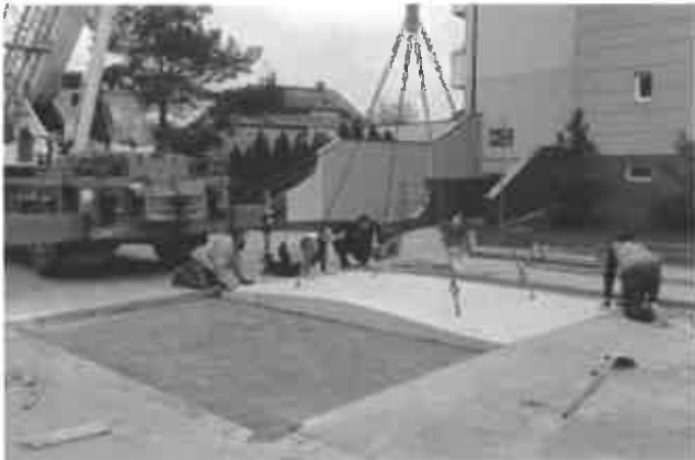
Zdjęcie 31 Montaż progu sinusoidalnego. Wroclaw, Polska
