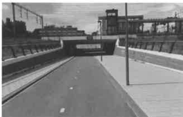
Zdjęcie 40 Bezkolizyjne skrzyżowanie linii kolejowej z główną drogą dla rowerów. Houten, Holandia
