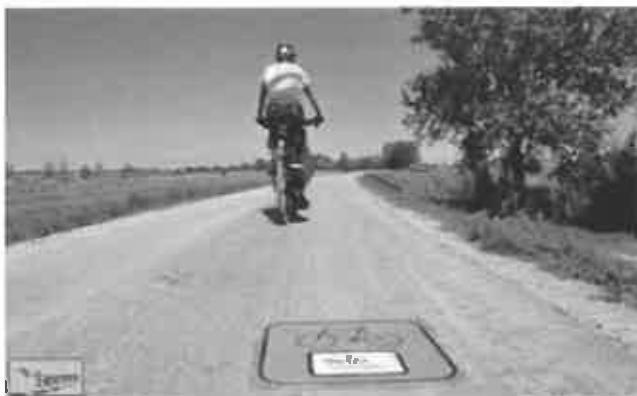
Zdjęcie 71 Oznakowanie poziome R-4 w ciągu VeloDunajec. Małopolska, Polska, termoznak.pl
