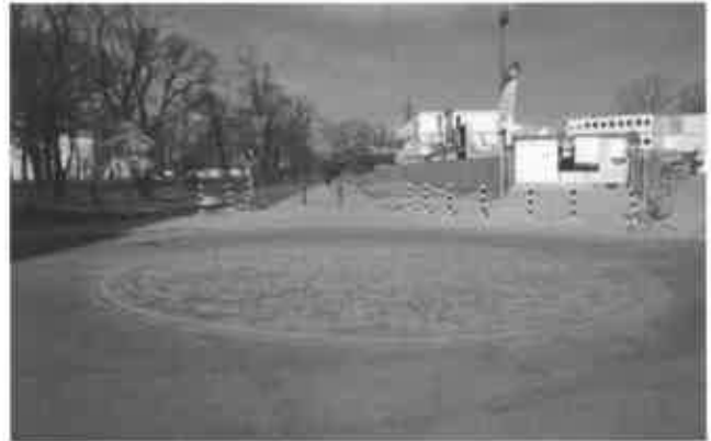
Zdjęcie 28 Droga dla rowerów jako samodzielny wlot na małe rondo, Wrocław, Polska
