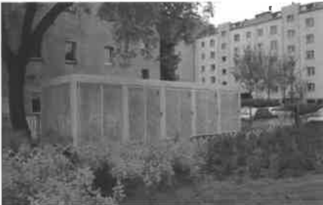
Zdjęcie 56 Zamknięty parking rowerowy w miejscu zamieszkania. Wrocław, Polska
