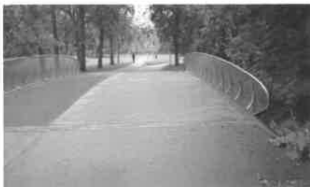
Zdjęcie 63 Kładka z barierą łukową. Amsterdam, Holandia
