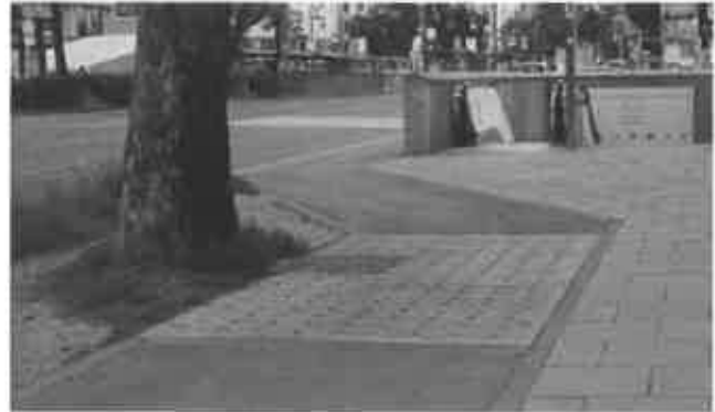
Zdjęcie 19 Płyta betonowa w ciągu drogi dla rowerów nad korzeniami drzewa. Niemcy
