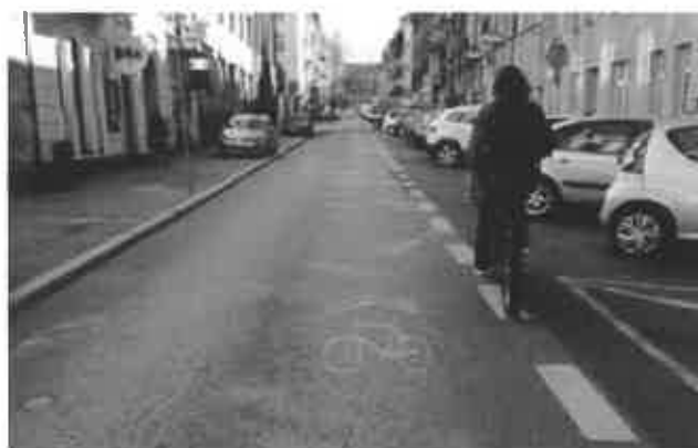
Zdjęcie 25 Kontraruch rowerowy. Katowice, Polska
