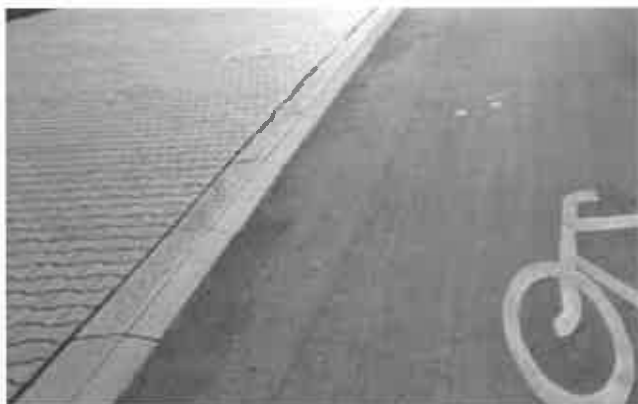
Zdjęcie 17 Obniżenie drogi dla rowerów względem chodnika przy pomocy krawężnika ułożonego „na płask”. Wrocław, Polska
