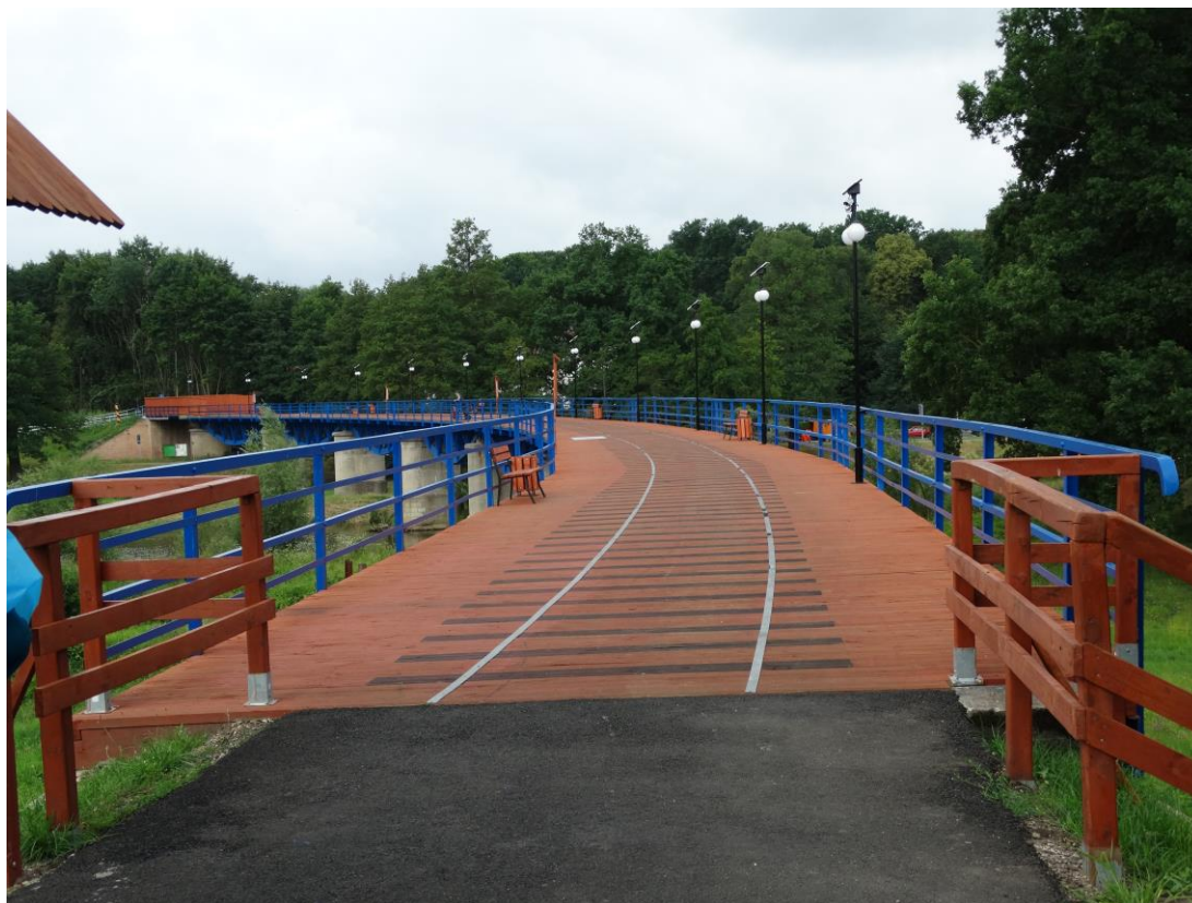
Łęknica/Bad Muskau. Dawny most kolejowy na Nysie Łużyckiej, obecnie kładka pieszo-rowerowa (foto autorów)
